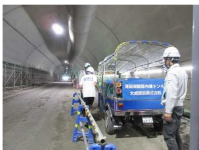
トックトックで坑内へ
