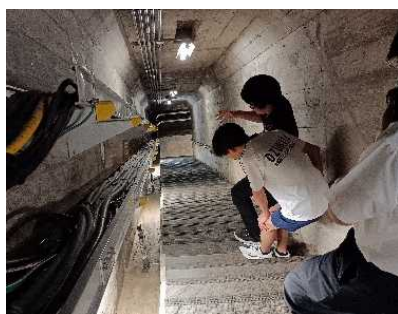
ダム監査廊見学
