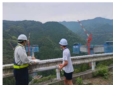
付替市道（新入船橋）見学
