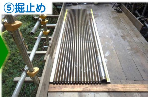
必要な深さや調べたい地層が採取された段階で掘止めとします。全てのボーリング資材の撤去を終え、土地の所有者の方に撤去完了のご報告をして現場作業が完了します。
