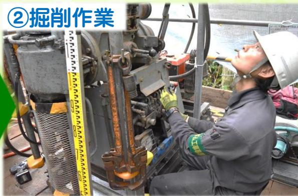
ボーリングマシンを使い、マシンの様々な変化に注意を払い丁寧に掘り進めます。工事看板設置やガードマン配置を行って、防音シートで囲い、安全第一で作業を行います。
