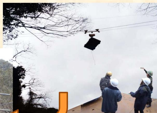
山と山の間にはワイヤーを張って、横坑から搬出した岩をのせたバケットをトラックまで運びます。
