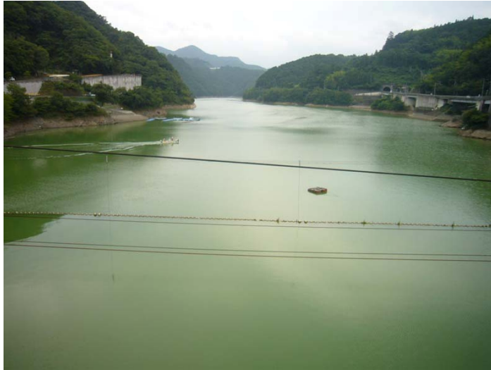
鹿野川ダム(H20年8月)
