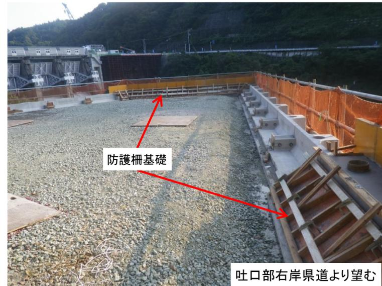
9月26日 軽量盛土工防護柵基礎コンクリート打設
