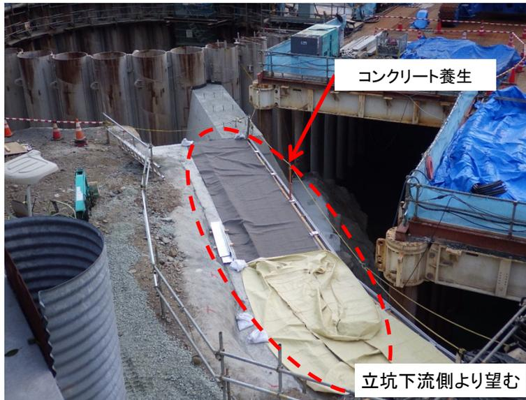
2月6日 天端床版コンクリート打設完了
