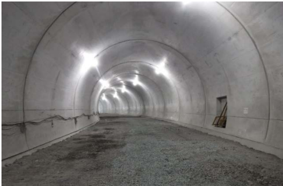
愛の森トンネルL=2,128m (R4.7.15貫通)
