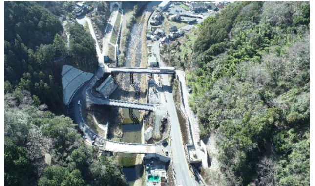
上鹿野川地区橋梁工事
