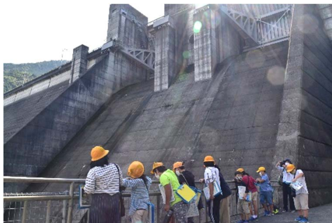
野村ダム施設見学会の様子
