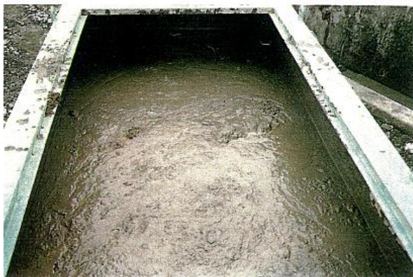
水密タンク積ダンプトラック積載状況
