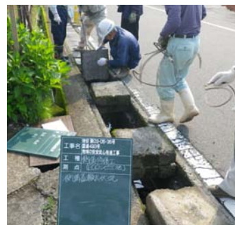
②既設側溝蓋撤去
