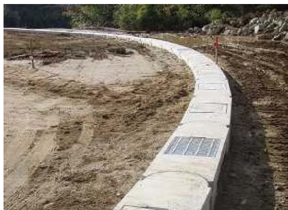
施工事例①
