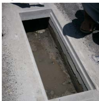
④二次蓋設置前
