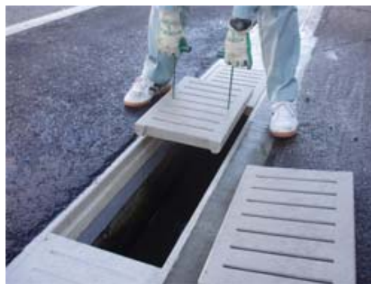
軽量二次蓋の設置
