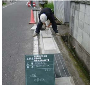
④二次蓋設置状況
