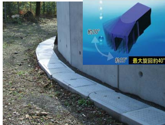
施工事例②
