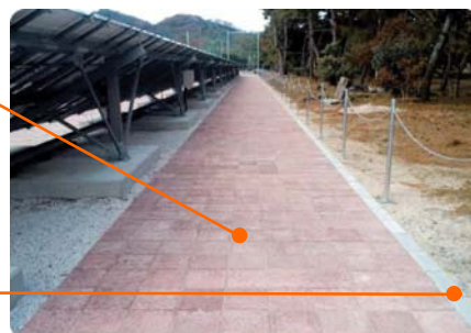
試験施工箇所状況（松山太陽光発電所）
