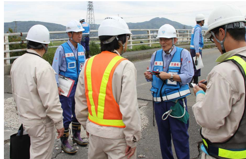
自治体への橋梁修繕に向けたアドバイス
