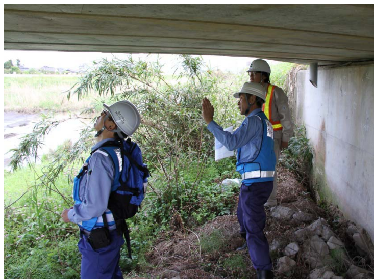
自治体に対し、橋梁状況を説明する田邊隊員
