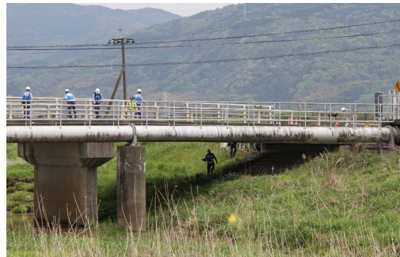
橋梁点検概要（上沼山津橋）
