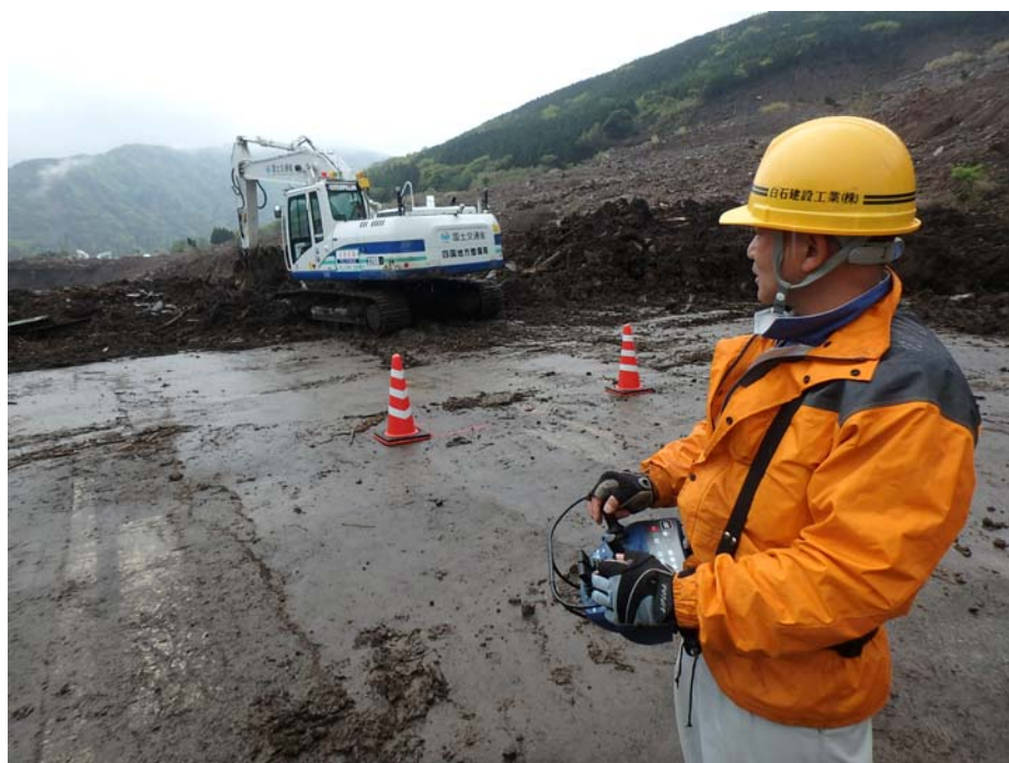
オペレーターによる遠隔操作の作業状況①
