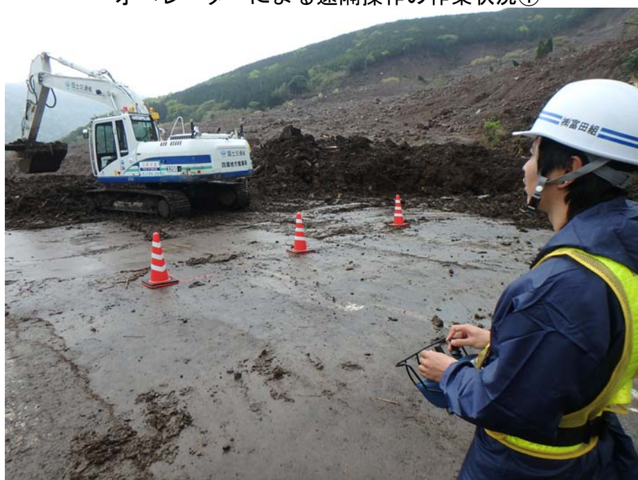
オペレーターによる遠隔操作の作業状況②
