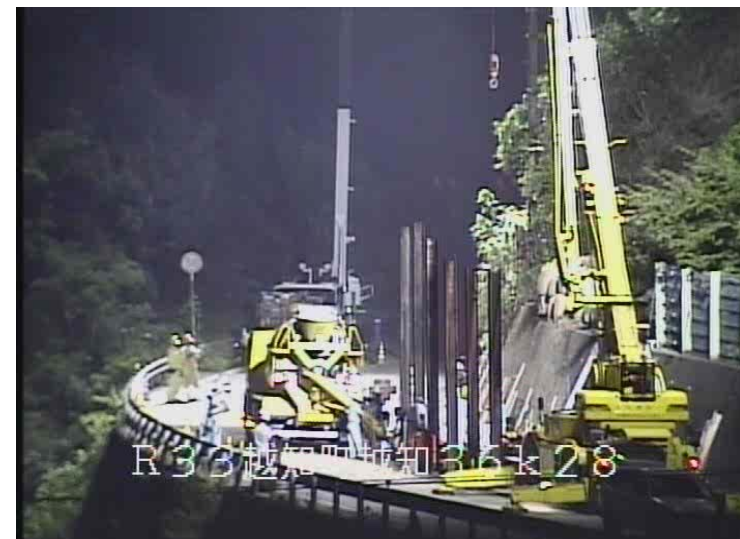
仮設防護柵（高さ5m）の設置中
