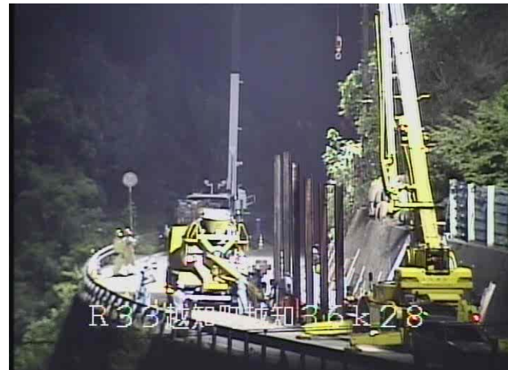
仮設防護柵（高さ5m）の設置中
