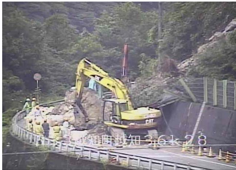
落下した岩塊の小割り作業実施中
