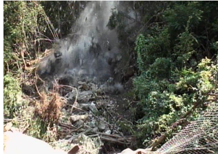
不安定岩塊を発破により除去
