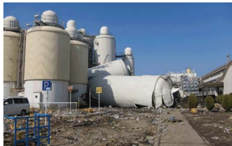
ビールタンクの倒壊状況
