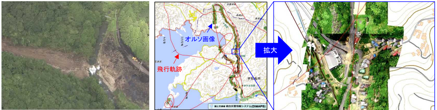
【令和6年台風第10号】 斜面崩壊による土砂流出の状況
