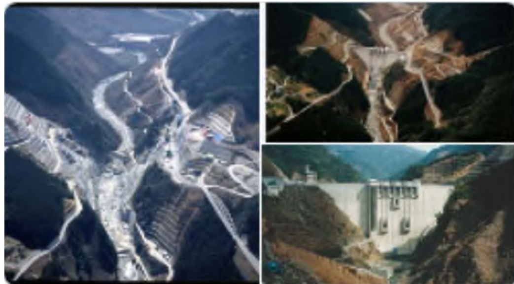
富郷ダム建設の様子
