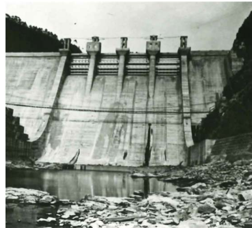
完成直後の柳瀬ダム
