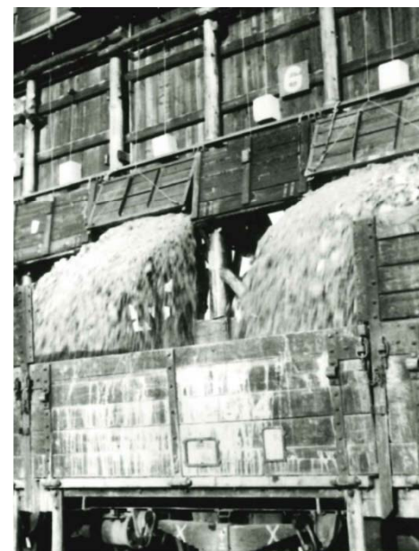
貨物車両へ骨材積込(本山)
