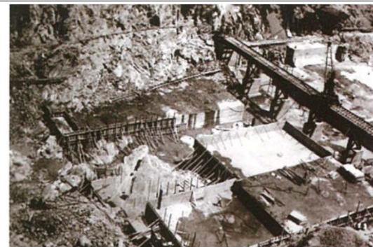
河床部のコンクリート打設
