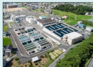
③中田井浄水場 四国中央市最大の浄水設備で日4万m3の浄水能力を有する
