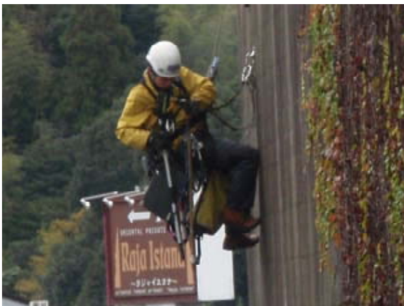
荷重架け替え状況
