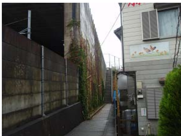
現地状況（A1橋台背面）
