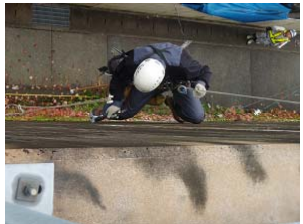
ハンマーによる打音調査
