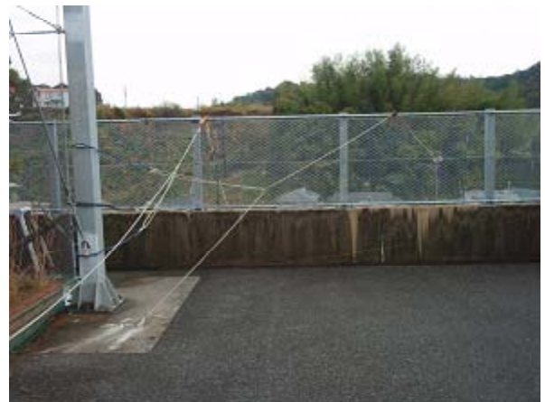
支点設置状況
