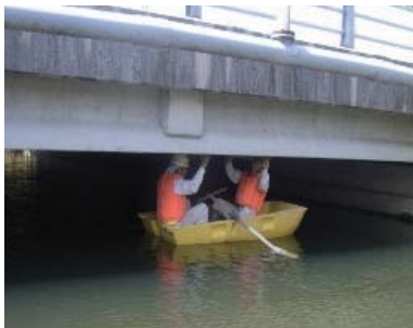
ボートによる点検状況
