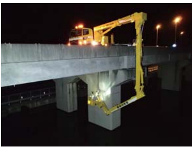
橋梁点検車による点検状況
