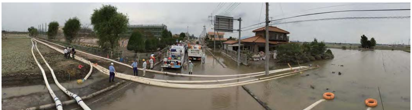
平成27年9月 台風17・18号による鬼怒川堤防決壊での排水支援状況
