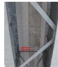
非破壊検査箇所(遠景)
