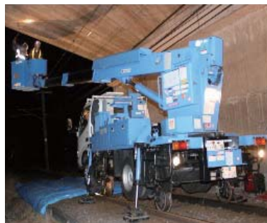
軌陸車による点検状況
