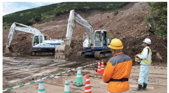
平成28年4月 熊本地震での遠隔操縦バックホウによる崩落土砂撤去状況
