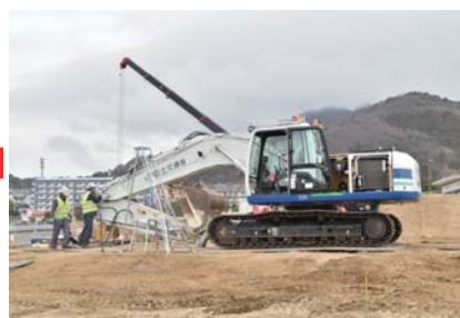
分解組立型バックホウの組立訓練状況
