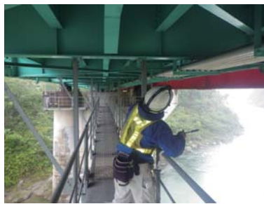
検査路からの点検状況
