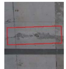
非破壊検査箇所(近景)
