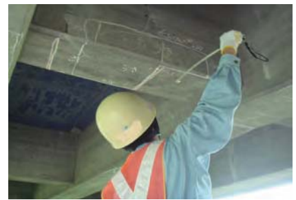
近接目視による点検状況
