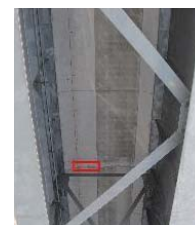
非破壊検査箇所(遠景)
