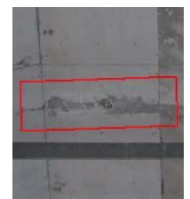
非破壊検査箇所(近景)
