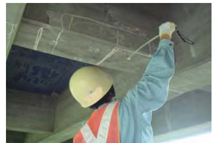
近接目視による点検状況
