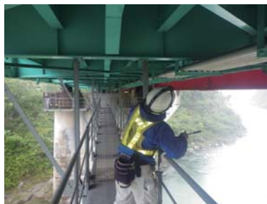
検査路からの点検状況
