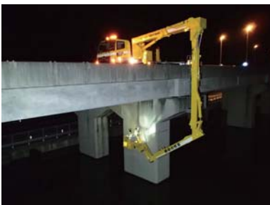
橋梁点検車による点検状況
