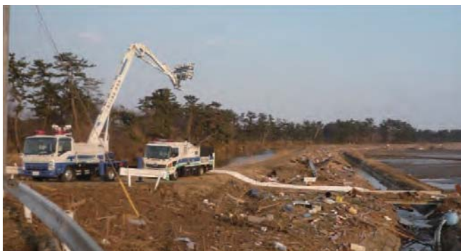
平成23年 東北地方太平洋沖地震での照明車による排水作業支援状況
