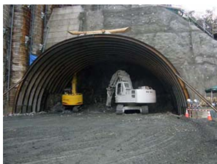
写真-11 トンネル坑口掘削状況
