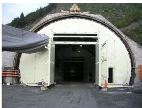
写真-5 防音扉 (イメージ)
