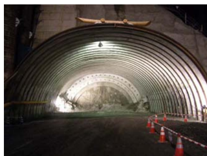
写真-12 トンネル坑口部機械掘削上半完了
