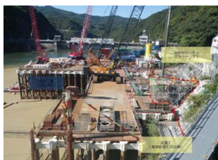
写真-8 呑口部施工状況
