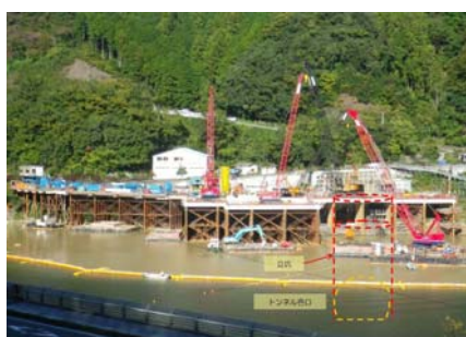
写真-7 呑口部全景(対岸より H24.12 現在)
