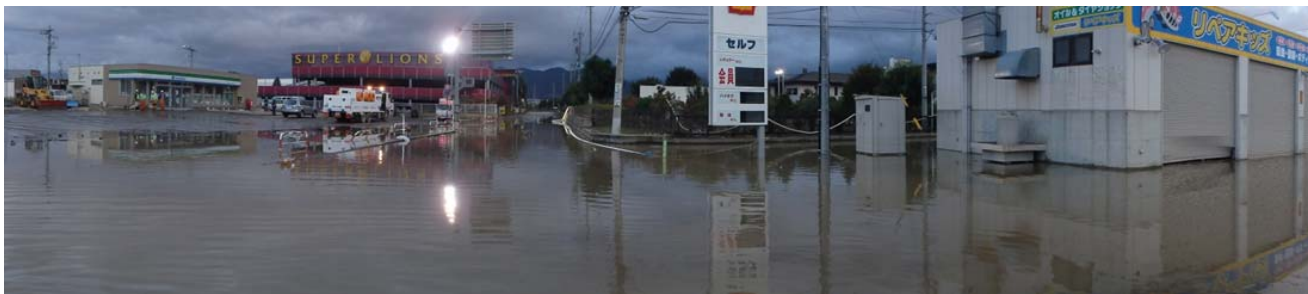
R1.10.15 排水ポンプ車による緊急排水状況 (長野県長野市)
