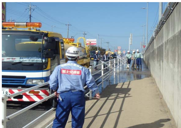
R1. 11. 2 応急対策班 側溝清掃作業 (栃木県佐野市)
