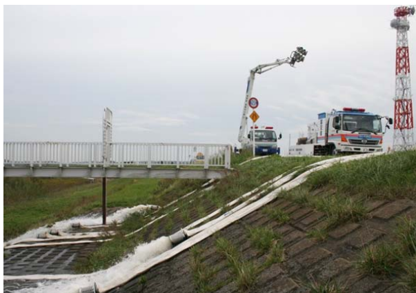
R1. 10. 27 応急対策班 排水作業 (千葉県印旛郡栄町（印旛水門）)
