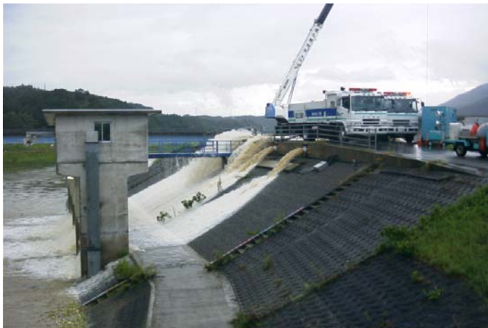
内水排除状況(肱川)
