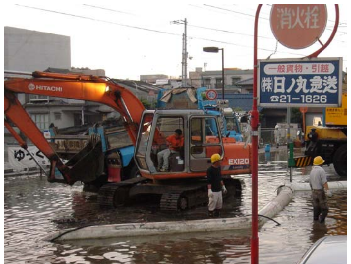
H16 台風23号 高潮被害(高松市) 道路を開削して排水
