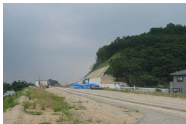
<計測箇所 (切土のり面)>
