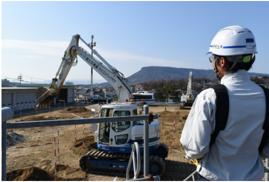
目視によるラジコン操作
