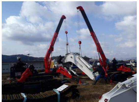
「⑥パーツ」組立状況写真
