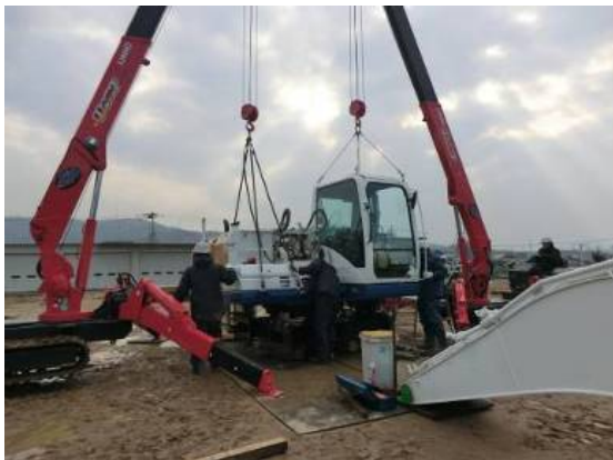
「⑤パーツ」組立状況写真
