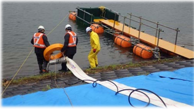
排水ポンプ投入
