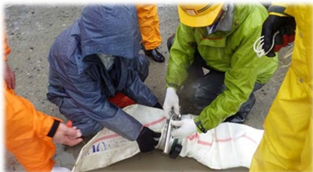
ホース接続状況
