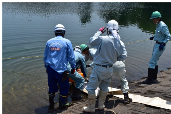
排水ポンプ投入
