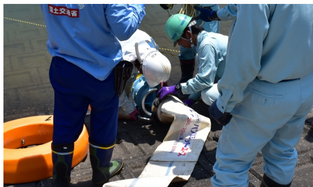
ポンプに排水ホースを接続
