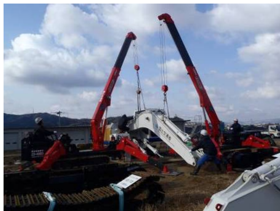
「⑥パーツ」組立状況写真
