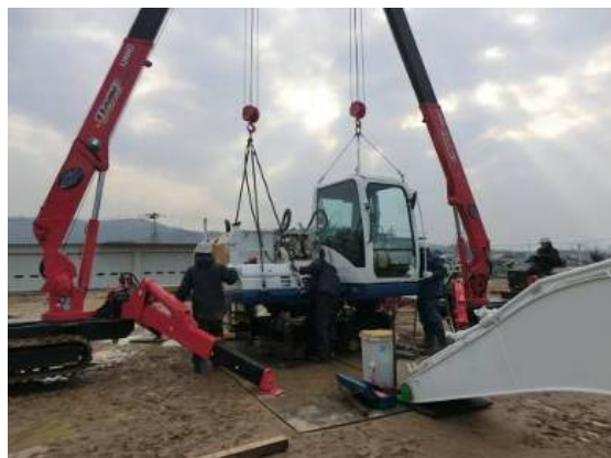
「⑤パーツ」組立状況写真
