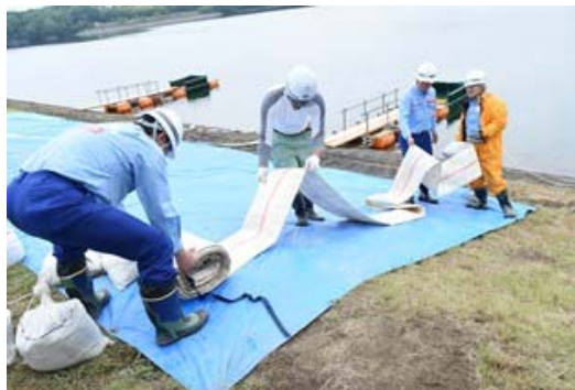
ホース接続、設置
