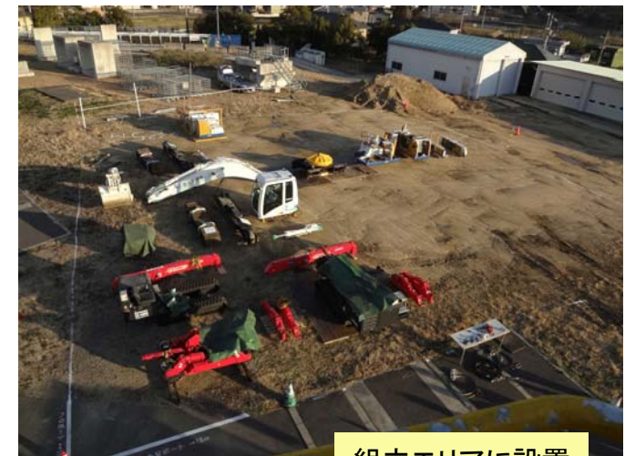
組立エリアに設置
