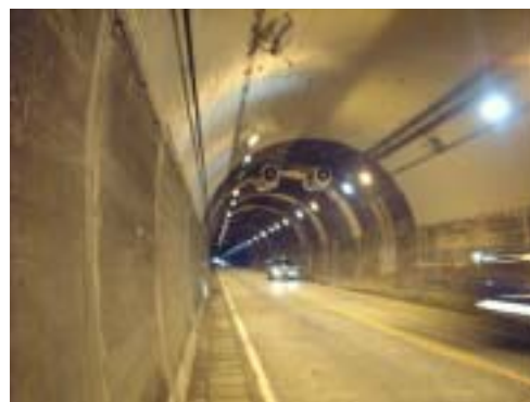
対策後(入口部照明区間)
