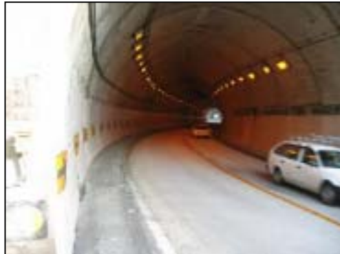
トンネル内の視線誘導標
