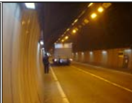
トンネル内の状況
