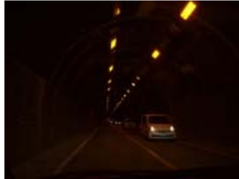
対策前(基本照明区間)
