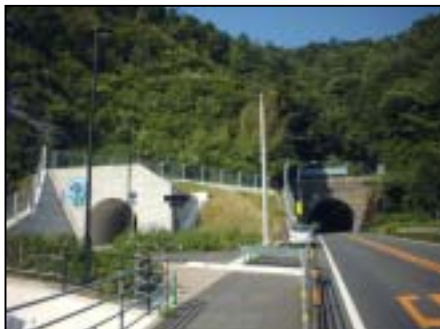
中村側坑口の現況
