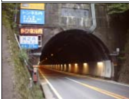
高松側坑口の現況
