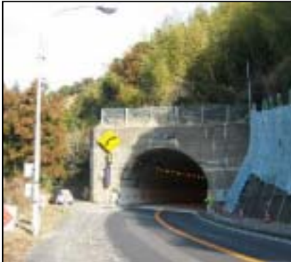
トンネル全景
