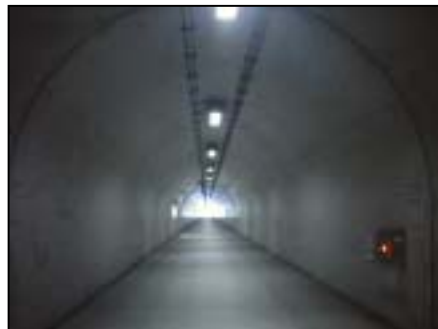
歩行者トンネル内部
