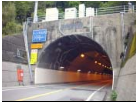
対策後(平成 15 年 8 月)
