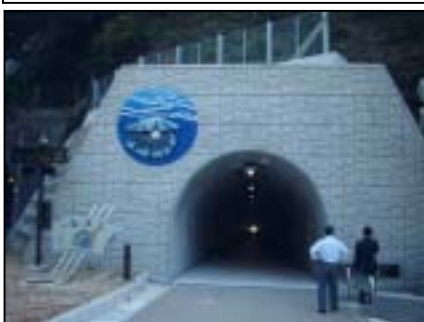
歩行者トンネル坑口
