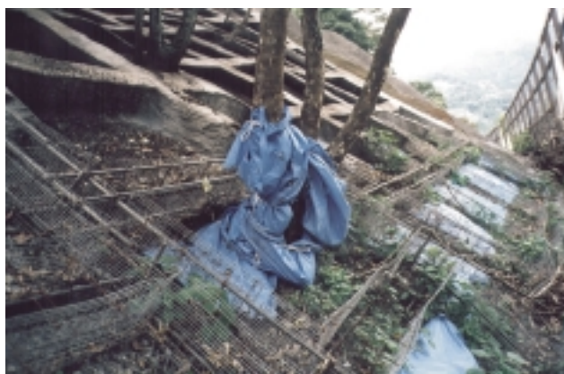
〈法枠未完成部分：鉄筋の設置状況〉
