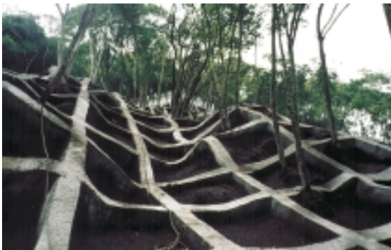
〈法枠完成部分〉
