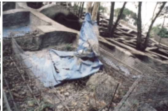
〈法枠未完成部分：既存木の養生の状況〉
