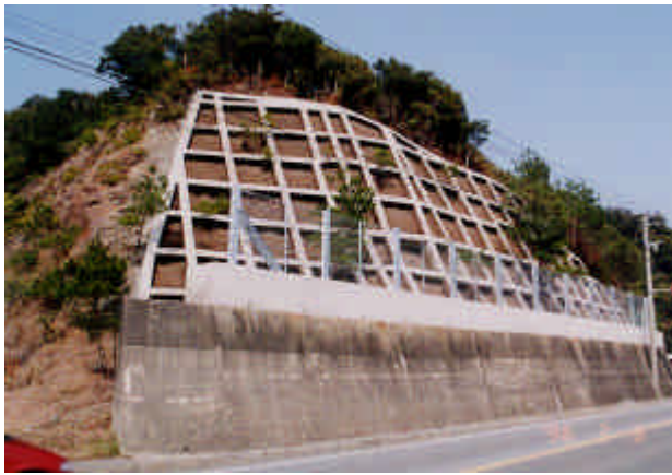
写真 - 3 55号海部5(C)工区 施工直後の状況
