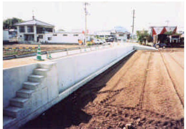
縦断勾配の付いた施工状況
