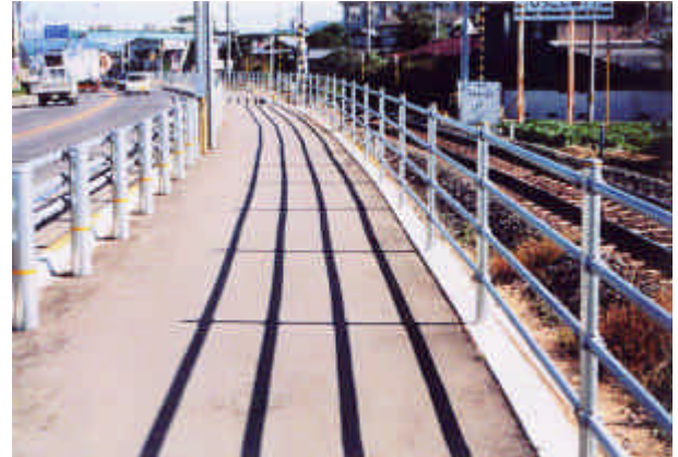
曲線部の施工状況
