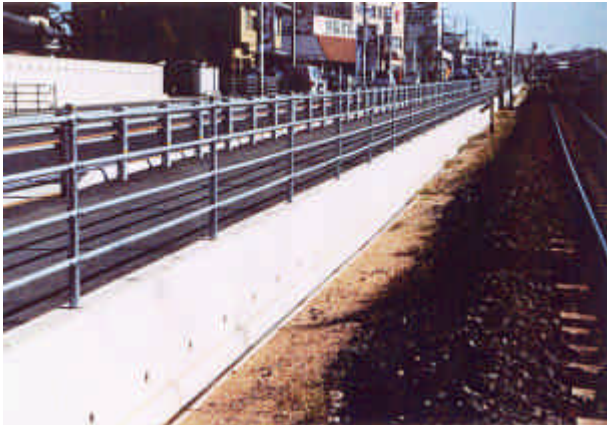
L型擁壁完成状況
