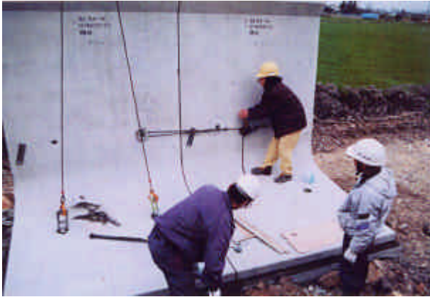
つり込み後ジャッキによる設置状況
