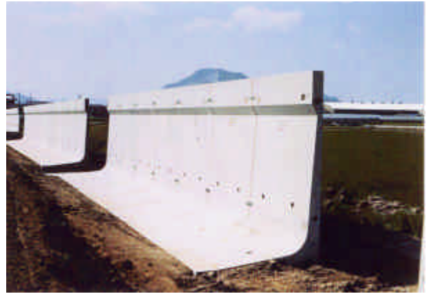
L型擁壁設置完了
