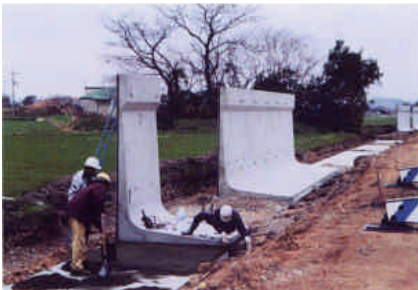
モルタルによる高さ調節
