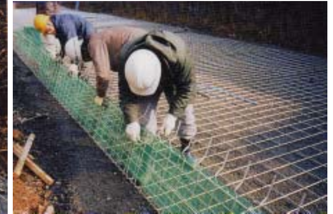
ジオメッシュ設置状況
