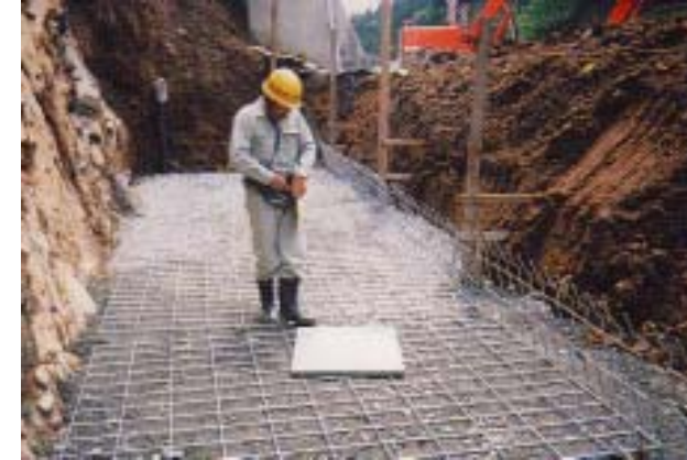
ワイヤーマット設置状況
