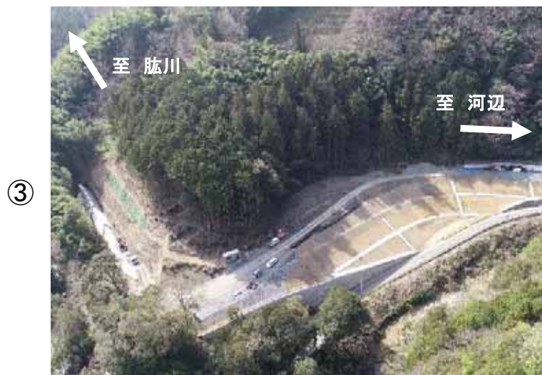
椽の木瀬地区付替県道 施工中(令和3年3月)
