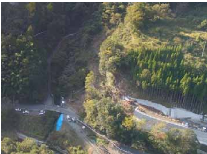
下敷水地区工事用道路 施工中(平成29年12月)
