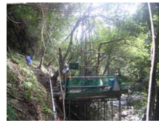
地質調査(ボーリング調査)
