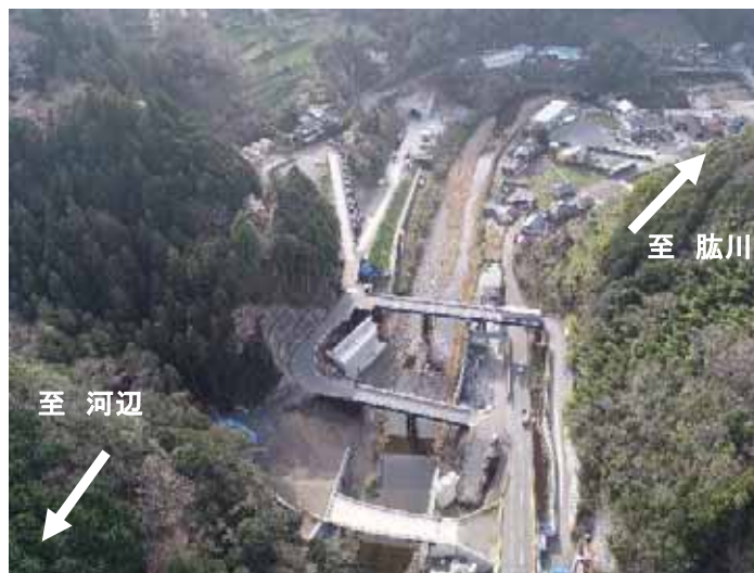
上鹿野川地区付替県道 施工中(令和3年3月)
