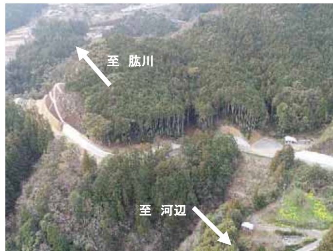
菟野尾地区付替県道 施工中(令和3年3月)
