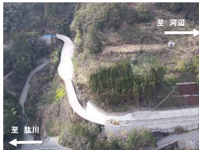
下敷水地区工事用道路 施工中(令和3年3月)
