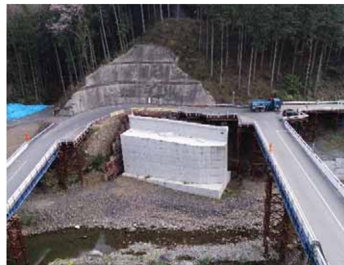
上鹿野川第1橋 施工中(令和3年3月)
