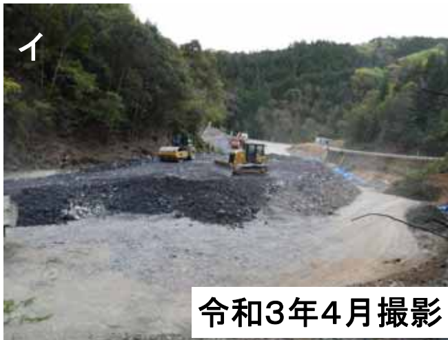
下敷水残土処理場に底面遮水工を施工
