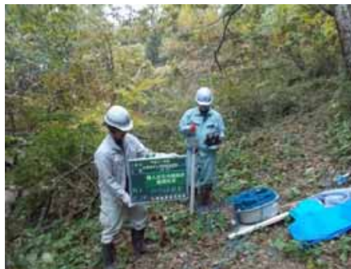
地すべり観測(孔内傾斜計観測状況)
