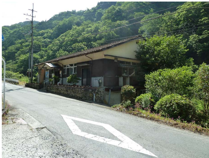
今後移転を予定してる公共施設(岩谷自治センター)
