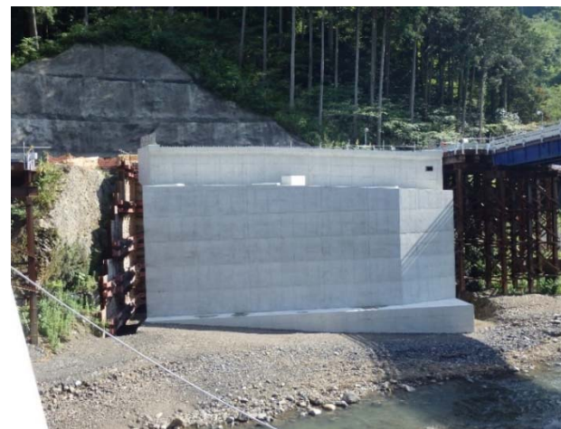
上鹿野川第1橋 施工中(令和2年5月)
