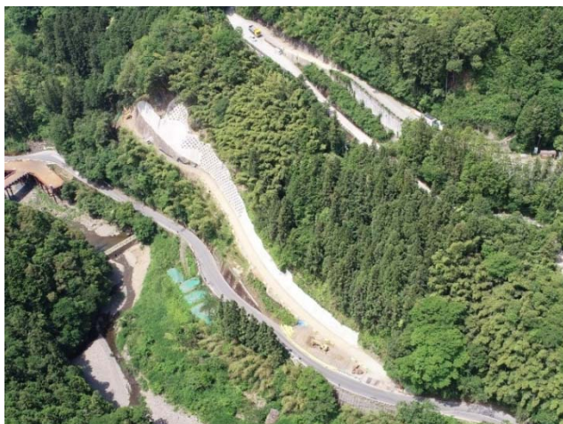
新入船橋工事用道路 施工中(令和2年5月)
