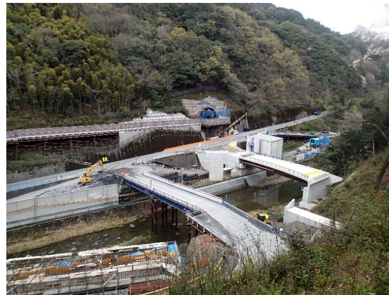
付替県道見の越トンネル坑口(終点側) 施工中(令和2年5月)
