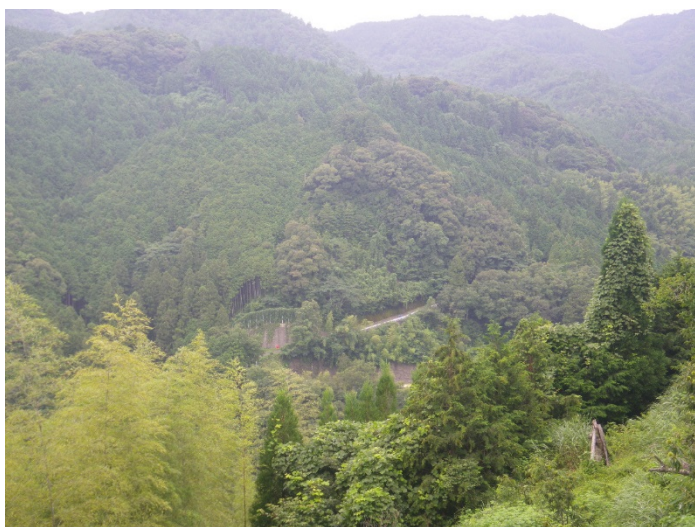
下敷水地区付替県道 着手前
