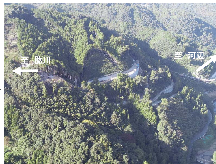
下敷水地区付替県道 着手後(平成30年10月)
