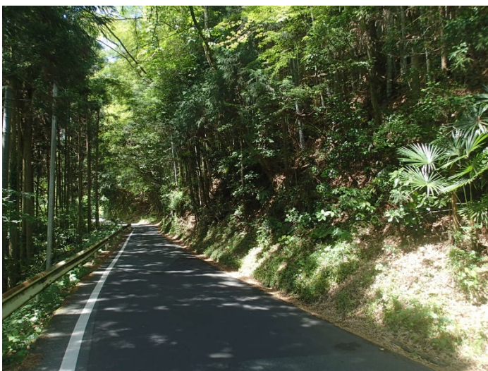
下敷水地区工事用道路 着手前
