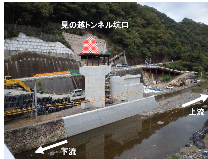
見の越トンネル坑口(終点側) 施工中(平成30年10月)
