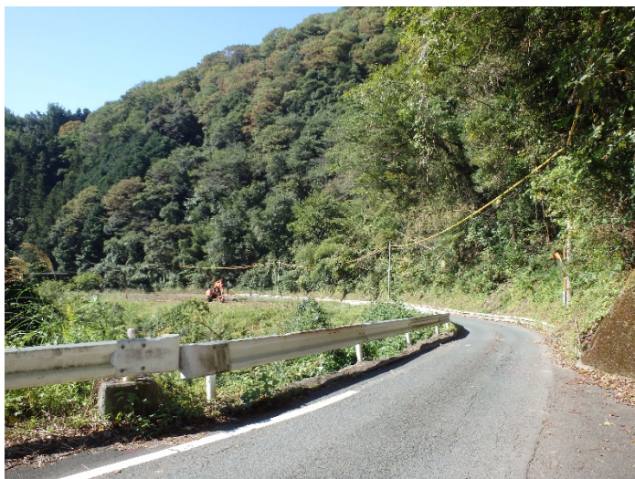
椋の木瀬地区付替県道 着手前
