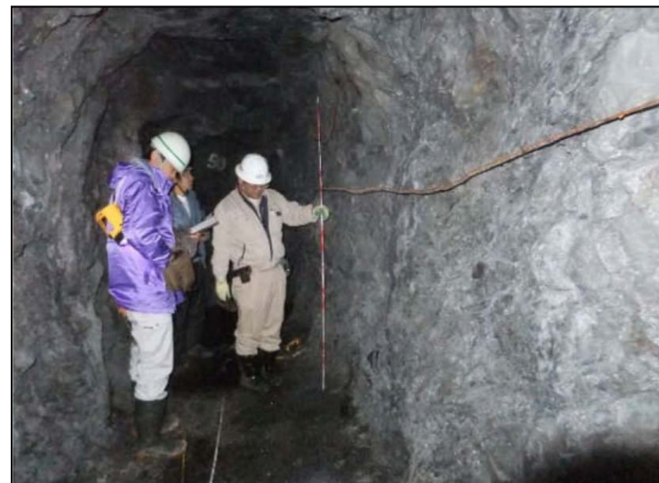
横坑内岩盤調査
