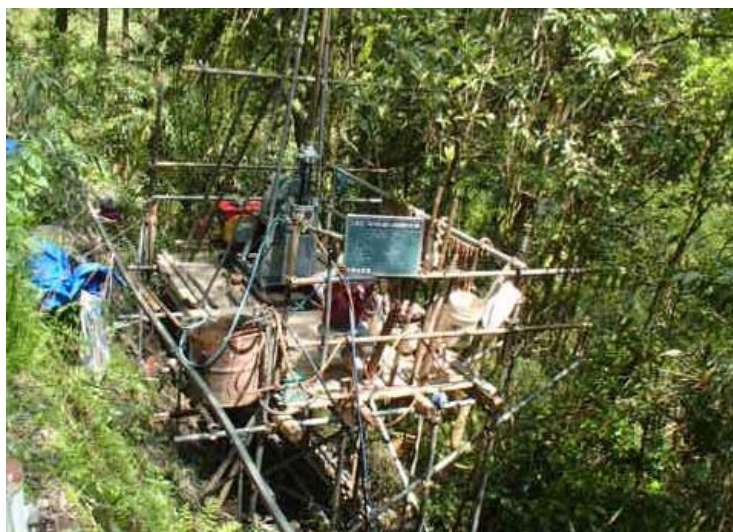
ボーリング調査
