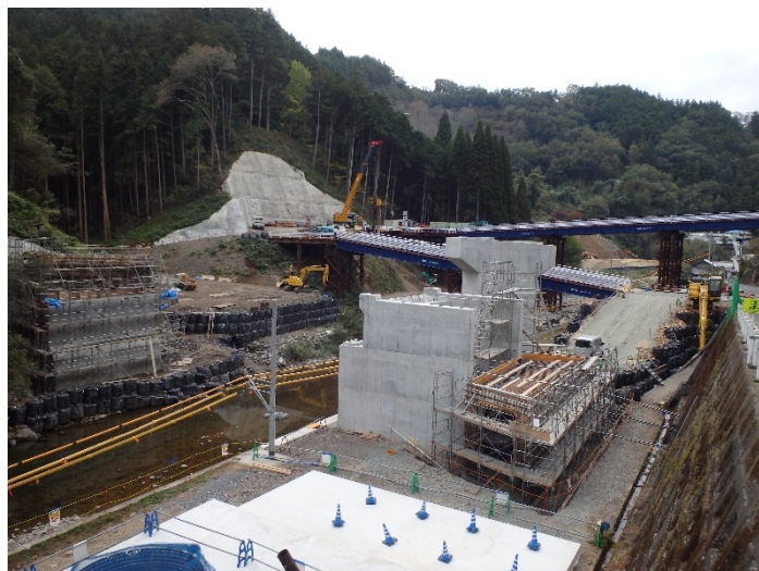
上鹿野川地区付替県道 施工中(平成30年10月)
