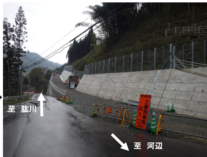
下敷水地区工事用道路 着手後(平成30年3月)
