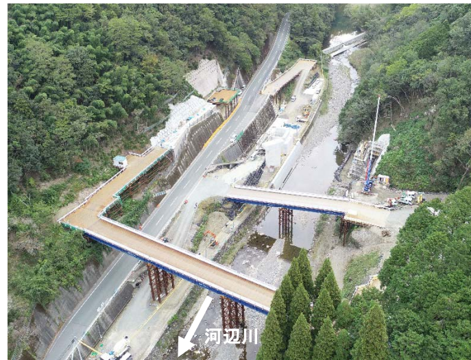
上鹿野川地区付替県道 施工中(平成30年10月)
