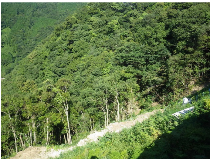
見の越地区工事用道路 着手前
