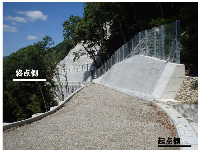
見の越地区工事用道路 着手後(平成30年3月)
