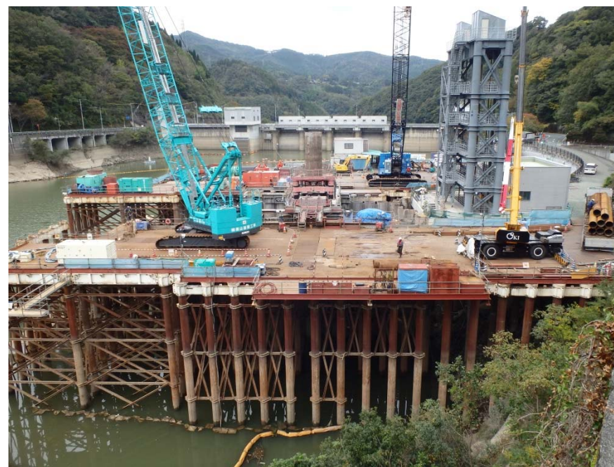
呑口施工状況(平成30年10月)
