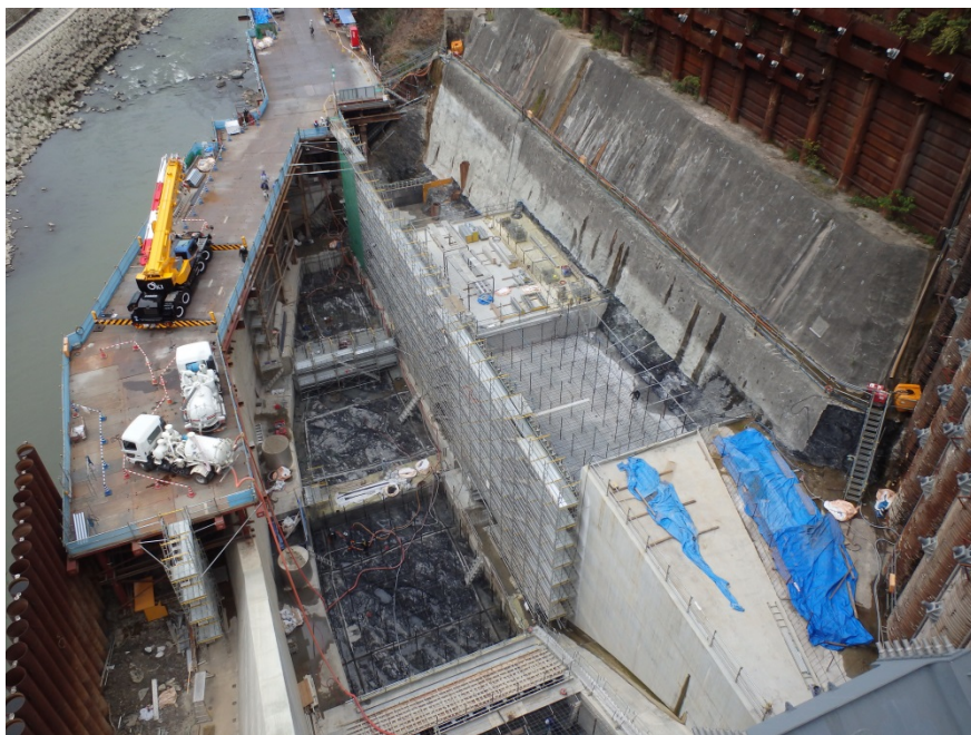
上流側ゲート室上部より臨む
