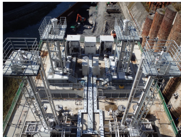
吐口部 放流設備据付状況(平成29年10月)
