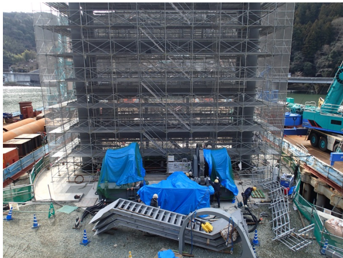
呑口部 門柱設置状況(平成30年1月)
