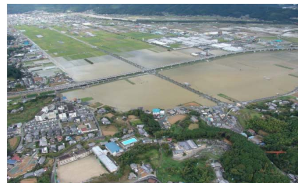
H17被害状況写真（東大洲地区）
