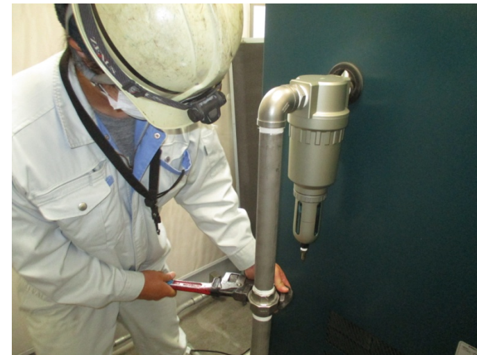
曝気循環装置の空気圧縮機修繕
