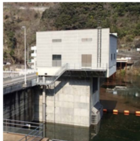
選択取水設備の設置 (H28年度完成)
