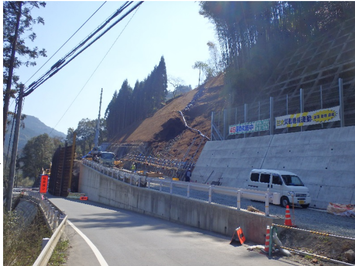
下敷水地区工事用道路 着手後(平成29年3月)
