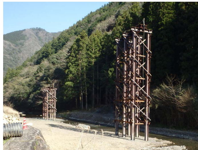
上鹿野川地区付替県道 施工中(平成29年3月)
