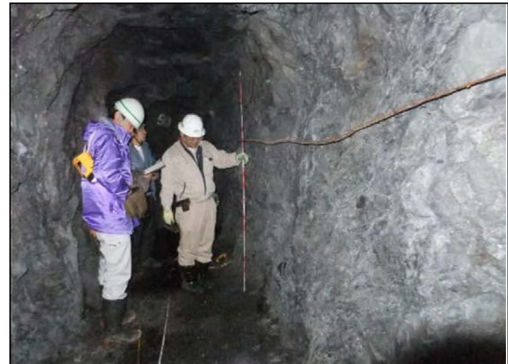
横坑内岩盤調査
