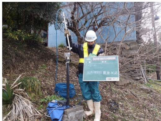
地すべり観測(孔内傾斜計観測状況)
