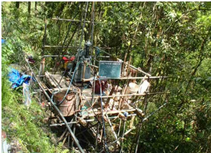
ボーリング調査
