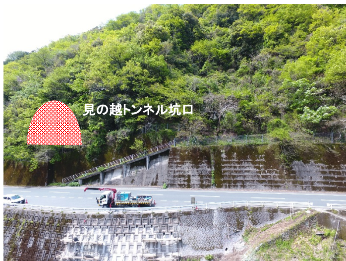
見の越トンネル坑口(終点側) 着手前(平成29年4月)
