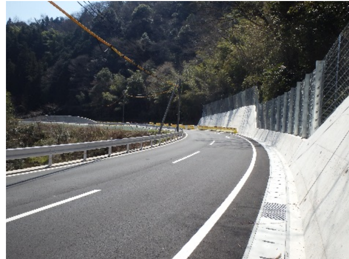
橡の木瀬地区付替県道 着手後(平成29年3月)
