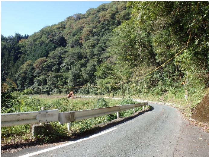
橡の木瀬地区付替県道 着手前
