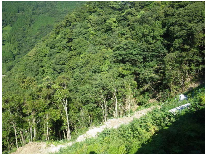
見の越地区工事用道路 着手前
