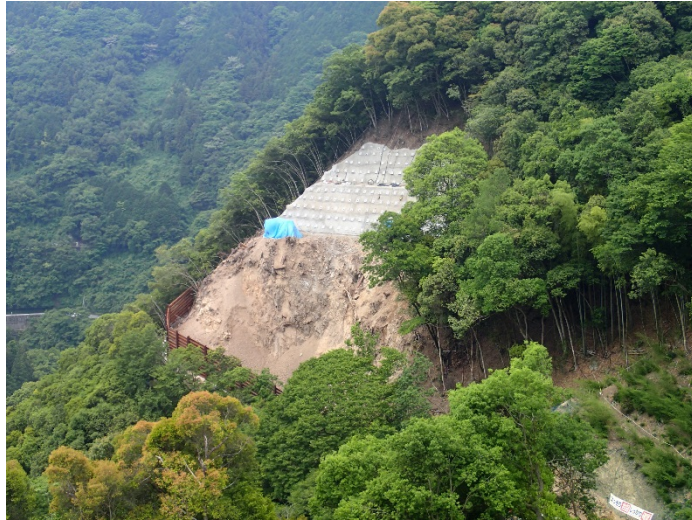
見の越地区工事用道路 着手後(平成28年3月)
