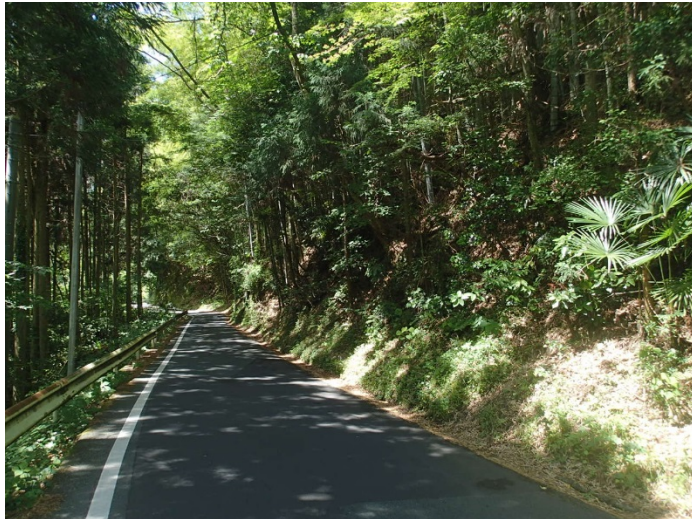
下敷水地区工事用道路 着手前
