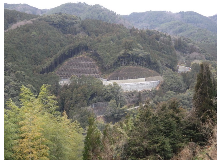
下敷水地区付替県道 着手後(平成29年3月)
