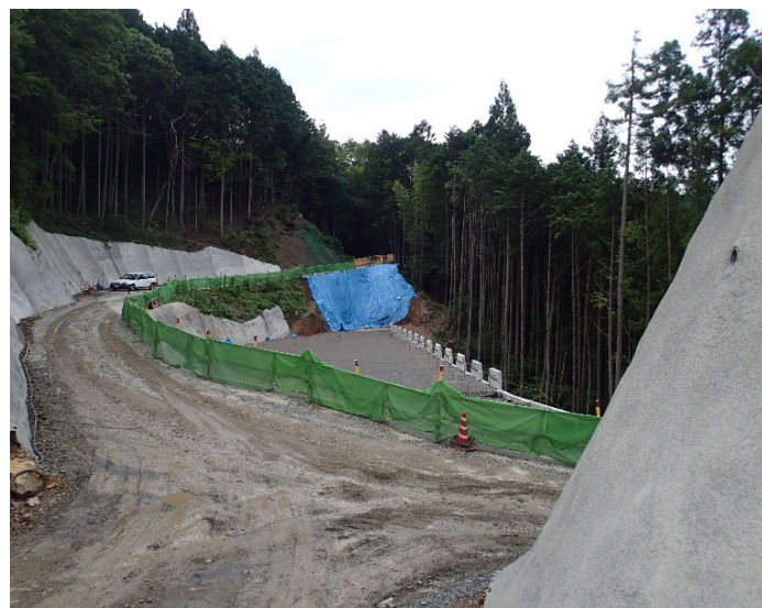
下敷水地区付替県道 着手後(平成28年3月)
