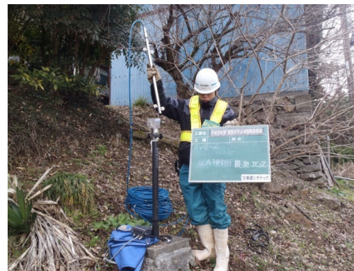
地すべり観測(孔内傾斜計観測状況)
