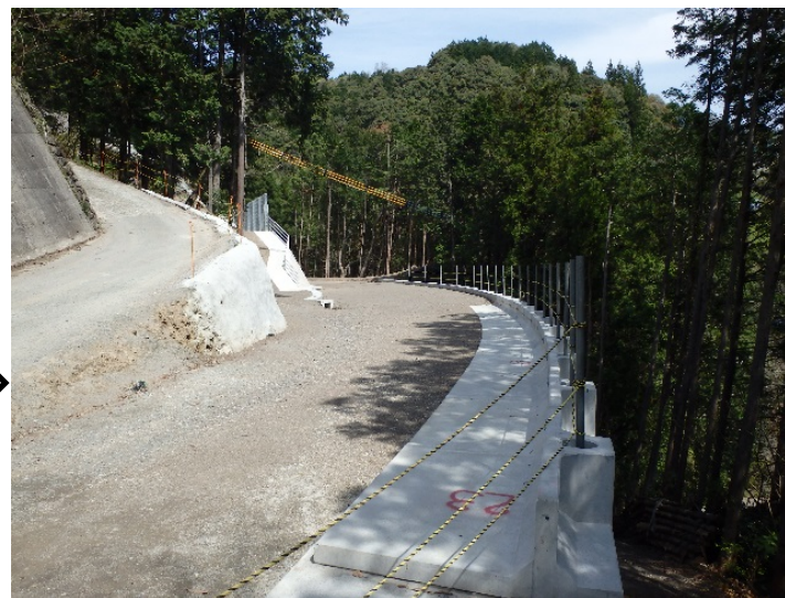
下敷水地区工事用道路 着手後(平成28年3月)
