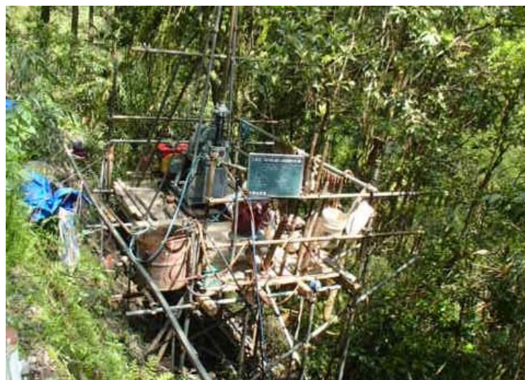
ボーリング調査
