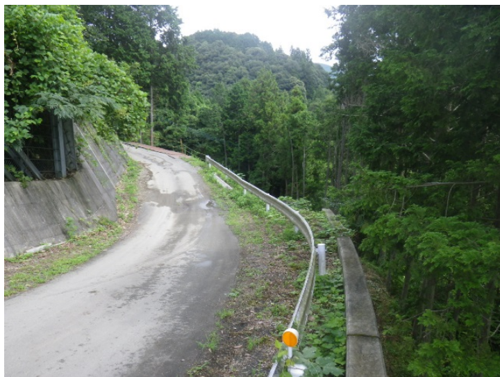
下敷水地区工事用道路 着手前
