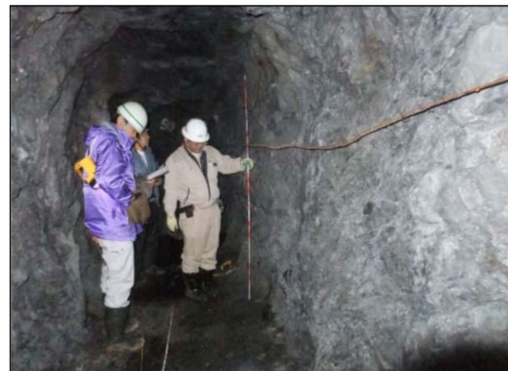
横坑内岩盤調査
