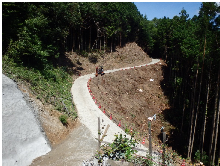
下敷水地区付替県道 着手前
