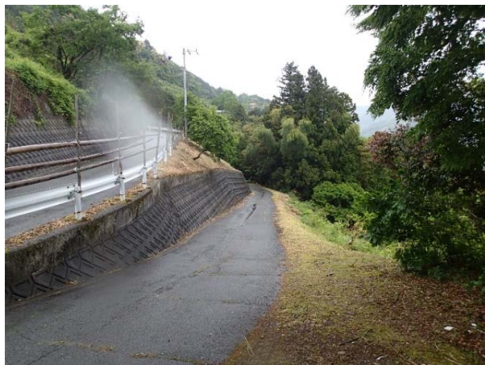
見の越地区工事用道路 工事着手前
