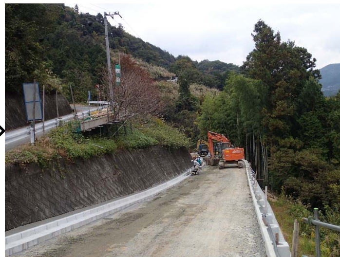
見の越地区工事用道路 工事着手後
