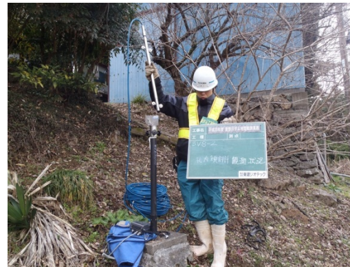
地すべり観測（孔内傾斜計観測状況）
