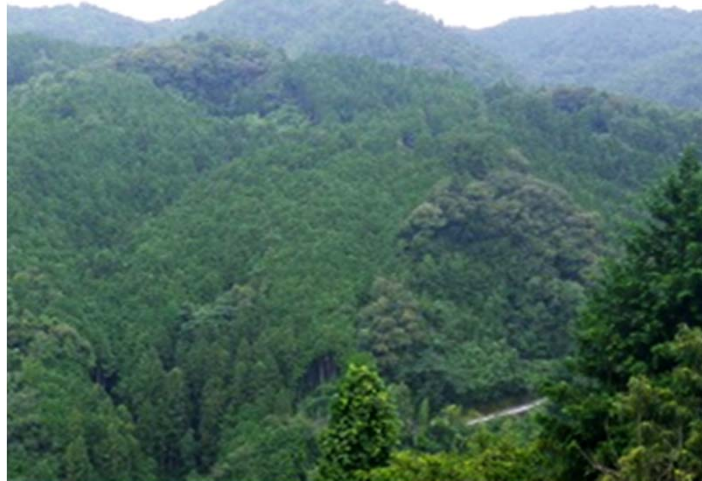
下敷水地区付替県道 工事着手前
