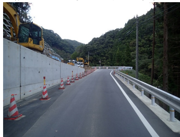
下敷水地区工事用道路 工事着手後
