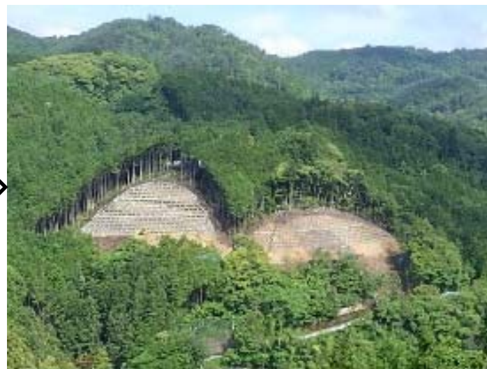
下敷水地区付替県道 工事着手後
