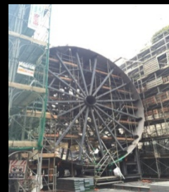
←(図1) 放流管は組み立てられたあと、トンネル内へ運び込まれる。
