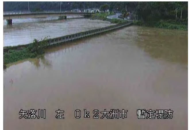
JR矢落川橋梁付近(7月7日11時頃)
