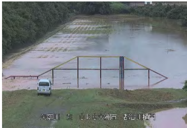
東大洲暫定堤防の状況(7月7日10時頃)
