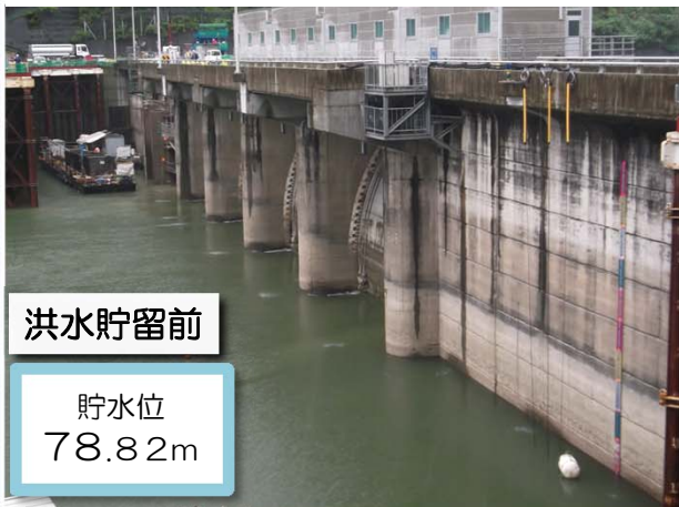
8月9日 15:10頃 鹿野川ダム湖 状況
